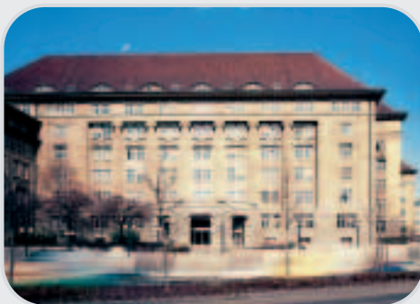
Bundesbahndirektion Heilbronner Straße
